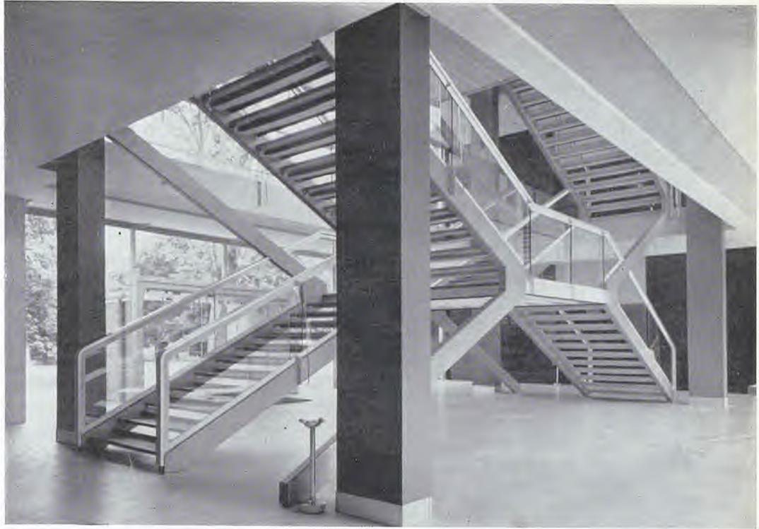
gitudinales; à chaque extrémité, des nervures transversales permettent le boulonnage sur les limons; un défoncé de 3 mm permet de coller un caoutchouc de revêtement sur la surface principale de passage. La rampe en acier reçoit une main courante en profilé A-GS traité par oxydation anodique. Les éléments de remplissage sont en glace trempée.
