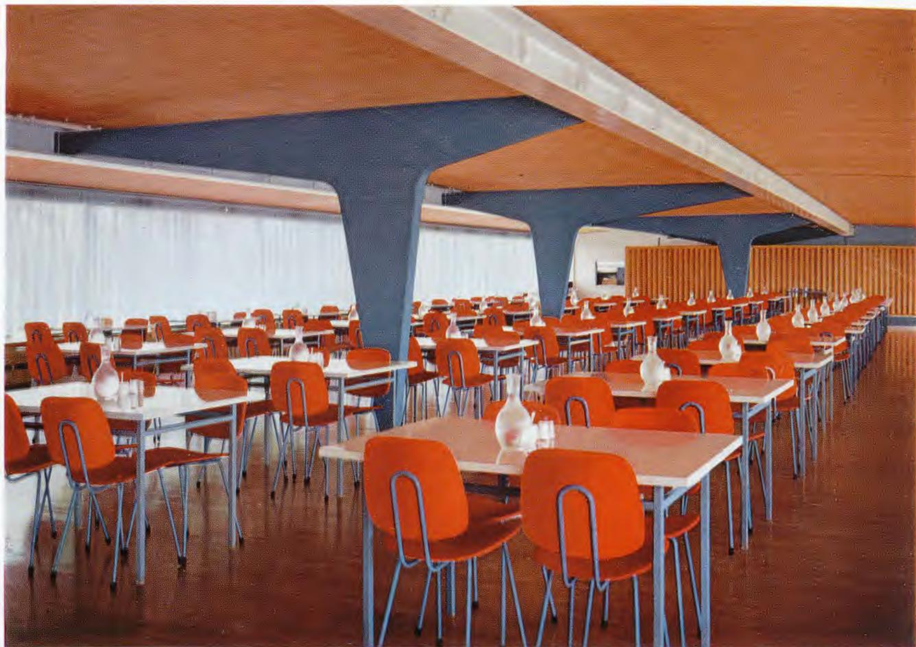
Fig. 18. — Vue d'ensemble de la salle de restaurant; à noter la disposition quinconcée des portiques ★ General view on the restaurant room; note the staggered arrangement of the portals ★ Vista de conjunto de la sala del restaurante; nótese la disposición al trespelillo de los pórticos.
