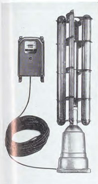
Fig. 4. — Ensemble anémométrique utilisé par E.d.F. pour la prospection de l'énergie éolienne.
