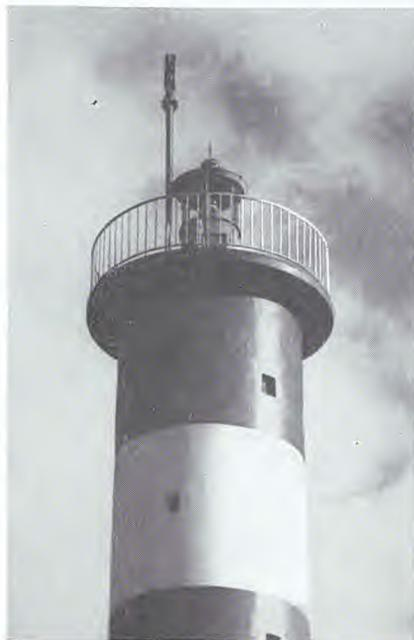
Fig. 5. — Ci-dessus, montage de l'antenne anémométrique sur un phare de la presqu'île du Cotentin ★ Above, assembling of the wind-gauge antenna on a lighthouse in the Cotentin peninsula ★ Arriba, montaje de la antena anemométrica en un faro de la península del Cotentin.
