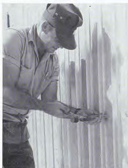
Les tôles d'aluminium utilisées sont, sauf exception rare, des tôles ondulées, striées ou cannelées, capables d'absorber les effets de dilatation par leur profil. Dans le sens long, les dilatations sont absorbées par l'élasticité des goujons.
